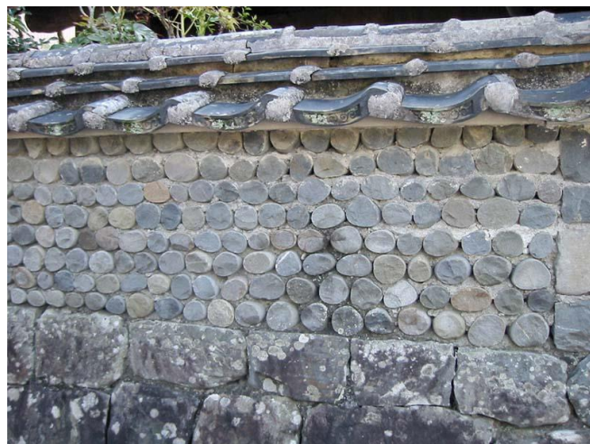
写真1. 吉良川のまちなみのいしぐろ。いしぐろに使われているレキのうち、丸い断面の縁が茶色く変色しているものがくさりレキ。
