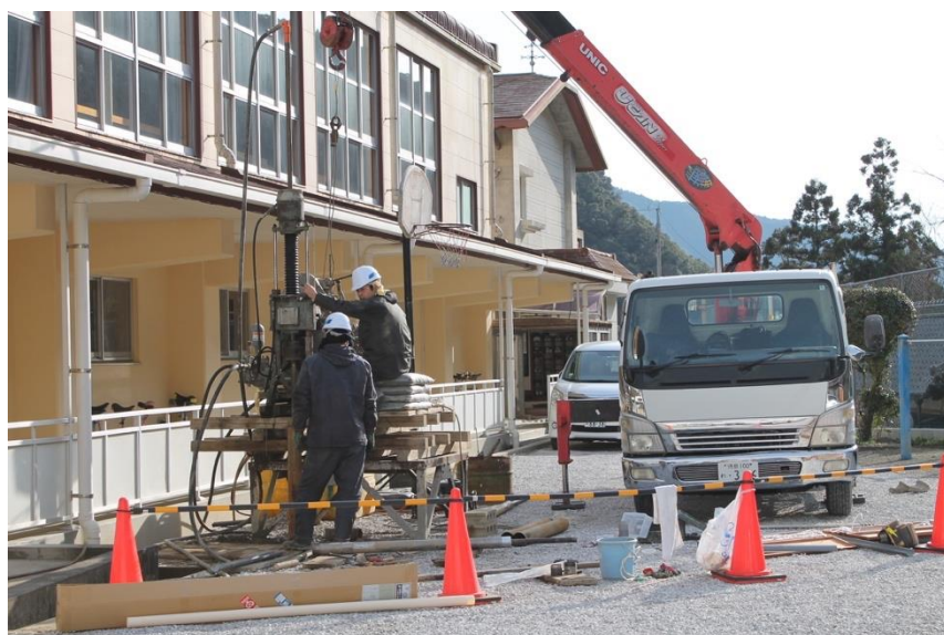
図 4 ボーリング掘削調査の作業の写真
