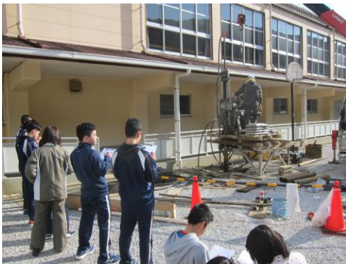
1 ボーリング掘削の作業の見学
